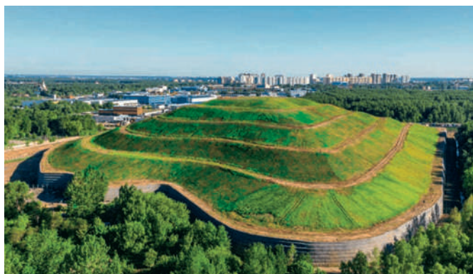
Рекультивированный полигон ТБО «Долгопрудный»
